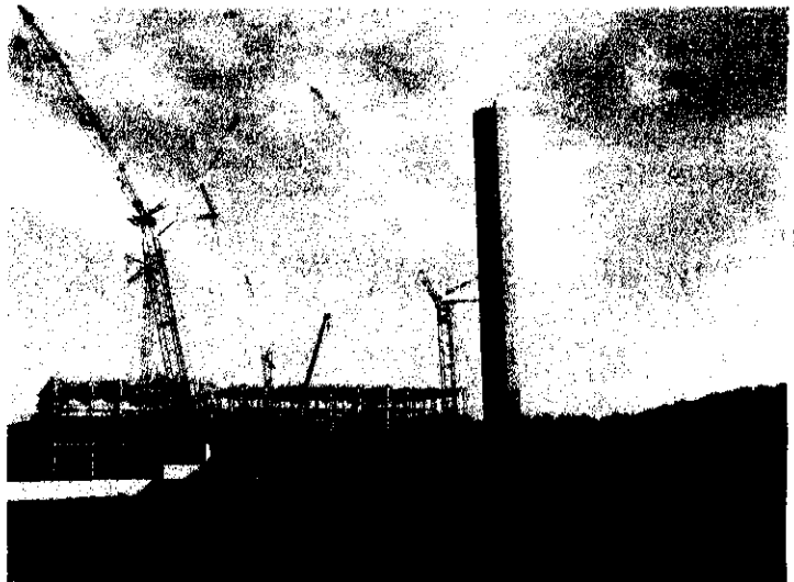
建設中の第2清掃工場 煙突の高さ100m
